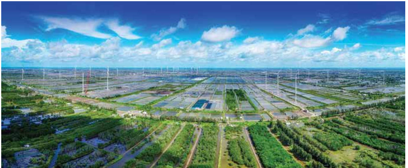
▲ Nhà máy điện gió Hòa Bình 5 tại huyện Hòa Bình, tỉnh Bạc Liêu (Ảnh: TTXVN)
