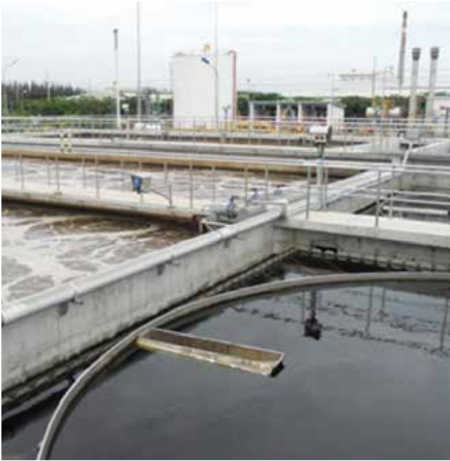
▲ Hệ thống xử lý nước thải KCN
